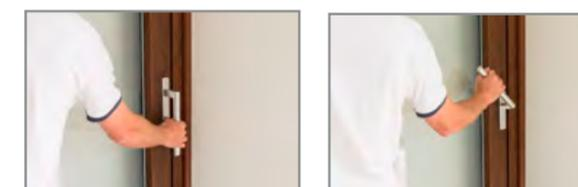
Con un simple movimiento de la maneta, la hoja se eleva y se desliza con total suavidad por los carriles.
