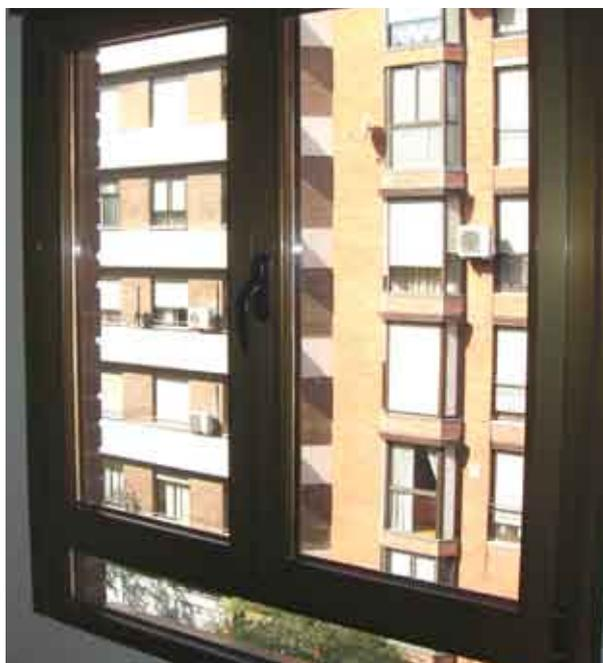
Esta tipología de cerramiento aparece en la edificación hacia los años 1990 como mejora en el comportamiento térmico de las carpinterías metálicas. Suelen ser carpinterías de mayor espesor y dotadas de buenos sistemas de apertura y cierre, no siendo habitual el sistema de corredera. Su
